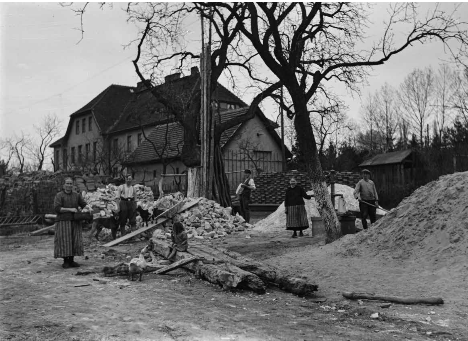
Prace porządkowe w miejscu rozebranego domu Fleischerów w Żyrowej, w tle widać budynek miejscowej szkoły (Katholische Volksschule), Żyrowa (niem. Zyrowa), około 1931 r.
